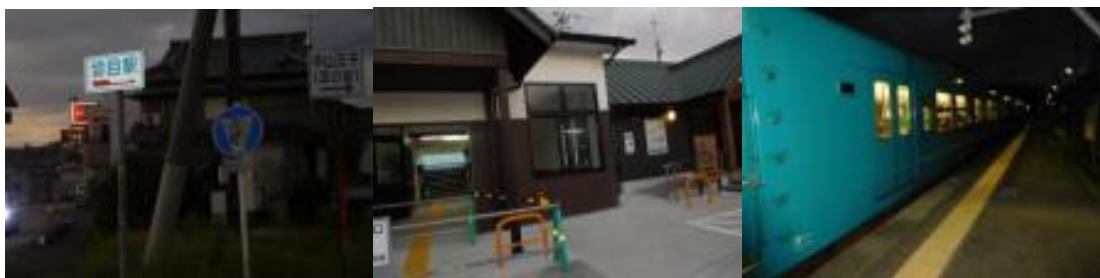
切目駅（駅工事中）
