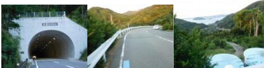
衣奈トンネル（全長 484m）、山間を歩く、前方に広川ビーチ登場
